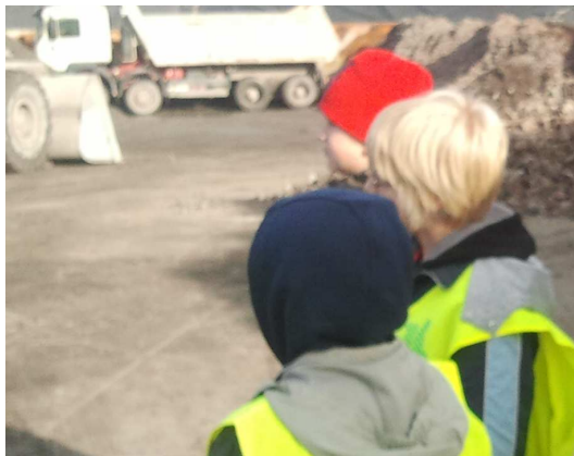
Rostaschenaufbereitungsanlage beim BAV
